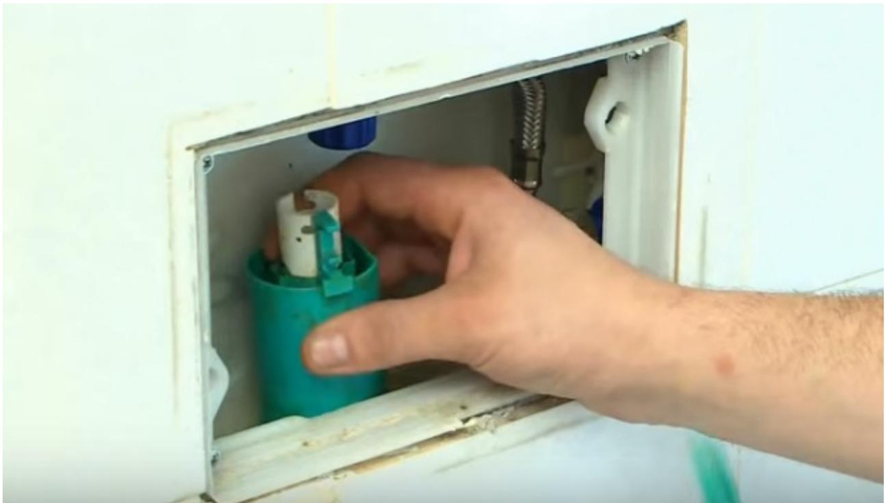
**WCD** è un prodotto appositamente preparato per il trattamento disincrostante di depositi di calcare che si formano all'interno delle cassette di risciacquo del WC. Perfettamente compatibile con parti e componenti plastici o di gomma, esercita la sua azione dissolvendo completamente le incrostazioni senza lasciare alcun residuo di calcare, ripristinando il corretto funzionamento del galleggiante e preservando le guarnizioni. Elimina alghe, sedimenti e depositi.
